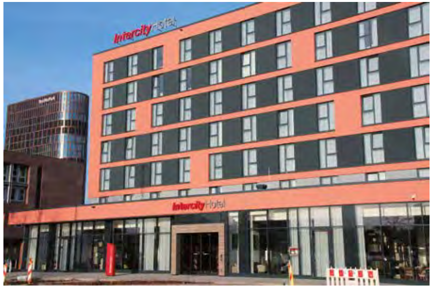
Das IntercityHotel Braunschweig ist nur wenige Meter vom Hauptbahnhof entfernt und liegt direkt am BraWoPark mit vielfältigen Einkaufsmöglichkeiten.
